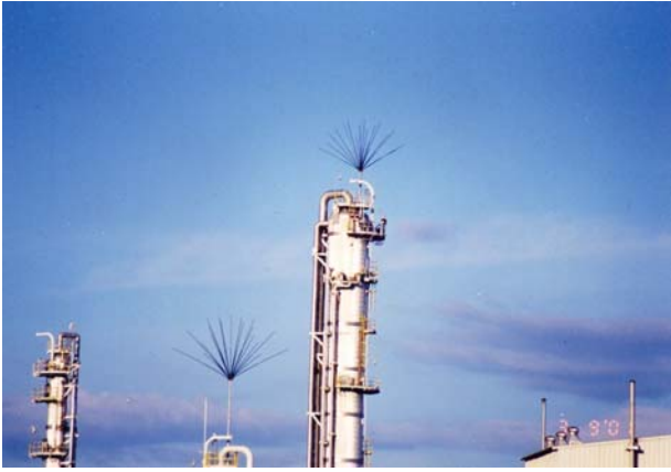
Fig. 10. Limitadores de corriente en una refinería. Cortesía de Hartono [14].
