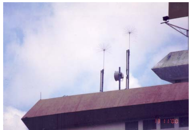
Fig. 9. Disipadores esféricos. Cortesía de Hartono [14].
